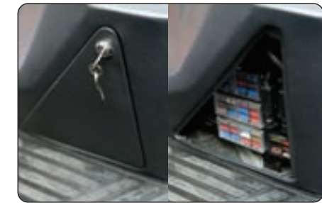
Servis erişim kolaylığı sağlayan yeni sigorta paneli
